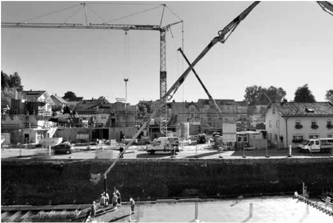
Großbaustelle »Neue Ortsmitte Altusried« – die Bürgerinnen und Bürger zeigten großes Verständnis für die Einschränkungen
