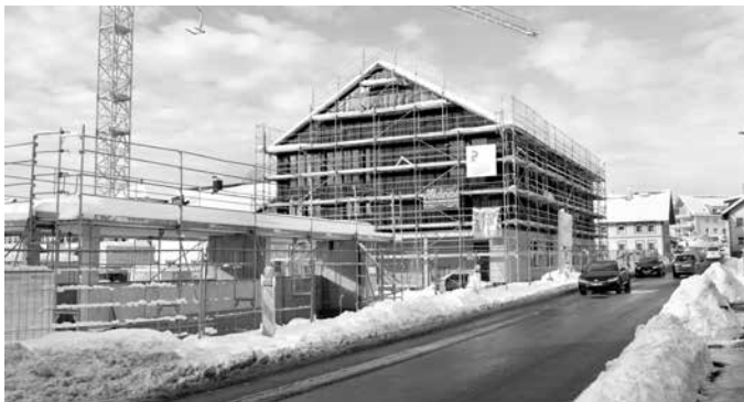
Großbaustelle Neue Ortsmitte Altusried, auf dem Bild das neue Rathaus
